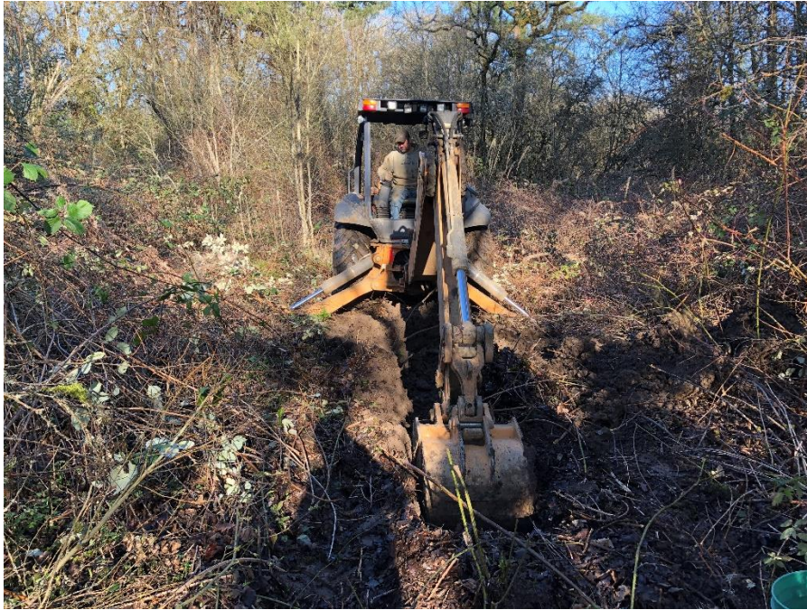
Test Pit TP-6
